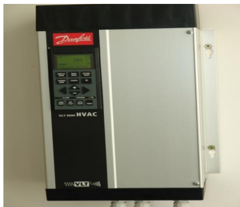
Ryc.20. Falownik do regulacji obrotów (wydatku) wentylatora
